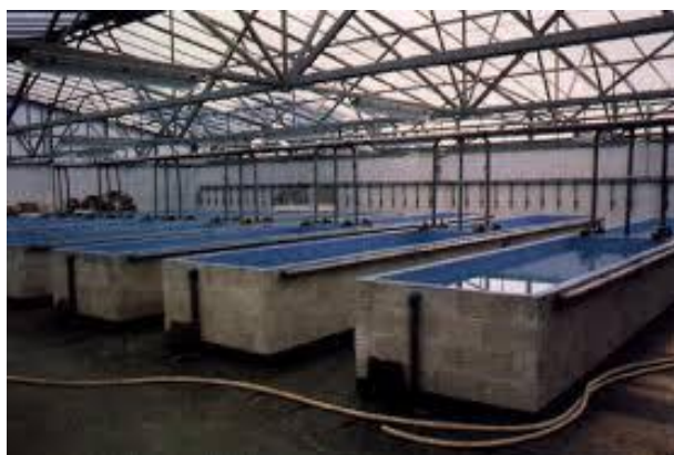
Figure I.3 : Bassins d'élevage piscicole de type « Raceway » (Zaghdoudi, 2013)
