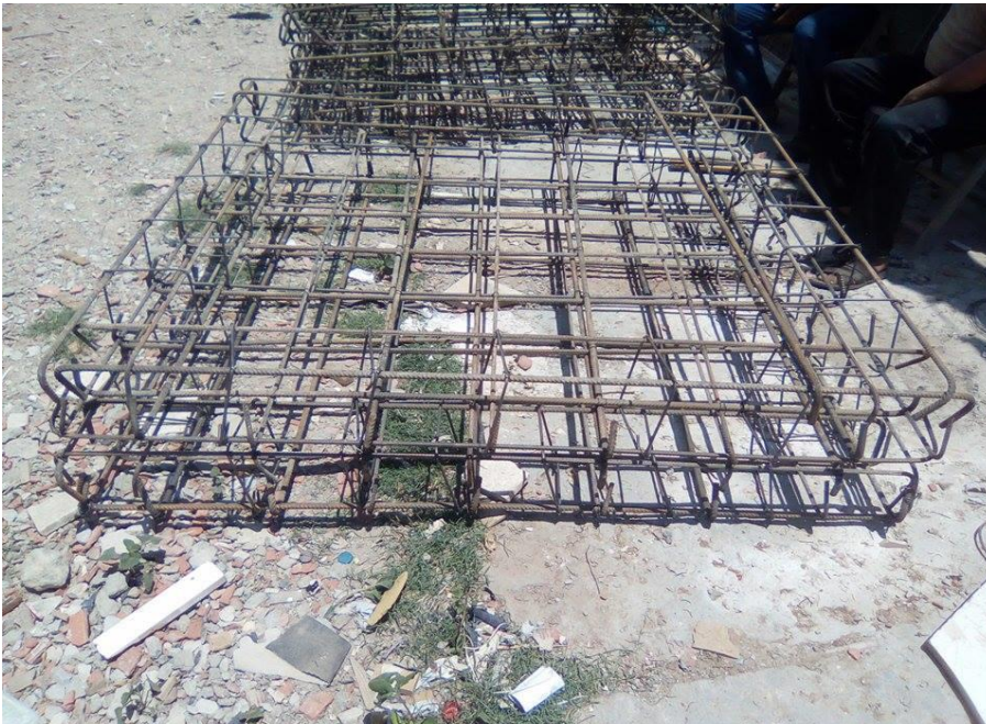
Figure 29 : le ferrailage du corps mort (Ben Salah Fadoua, 2016)
